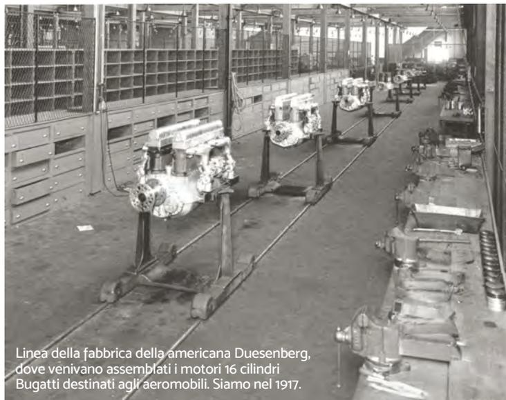
Linea della fabbrica della americana Duesenberg, dove venivano assemblati i motori 16 cilindri Bugatti destinati agli aeromobili. Siamo nel 1917.
