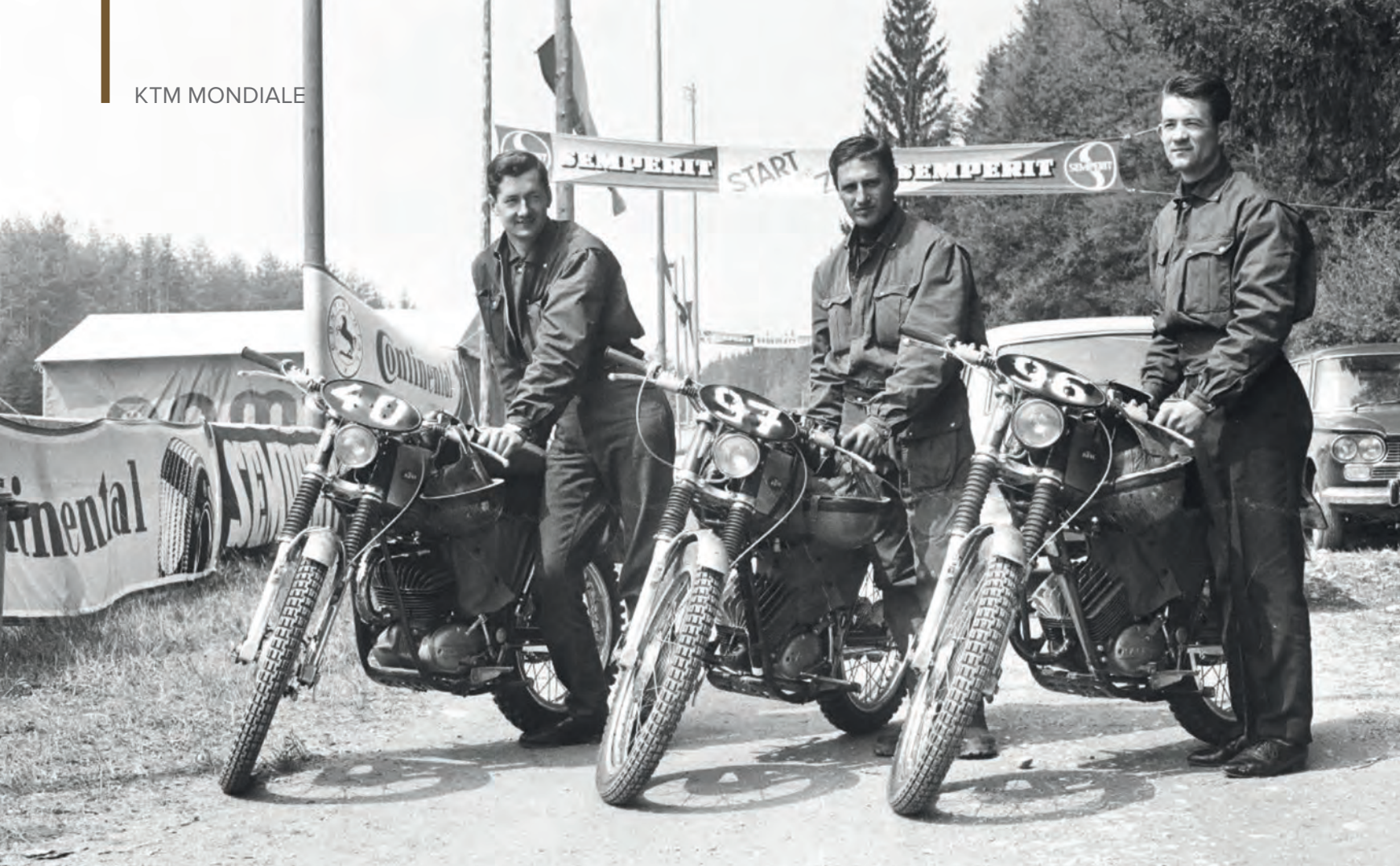
Tre moto della KTM nel Giro delle Alpi Austriache il 10 maggio 1967: la 133 sperimentale di Tony Kiemeswenger (n°40) e i "cinquantini" di Gerhard Weber (n°97) e Siegfried Stuhlberger (n°96) con i cilindri in alluminio con il riporto di NiKaSil nella canna.
